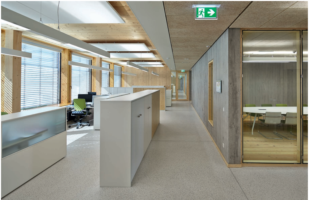
Ablesbares Material- und Konstruktionsprinzip am Beispiel der offenen Südbüros; Holzelementdecken- und Stützen, Betonkern mit Sichtbrettschalung und geschliffener Zementestrich
