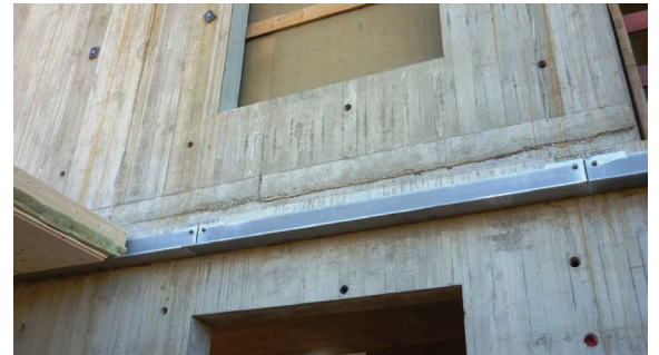
_Auflagerung der Holzdecken an den Stahlbetonwänden des Gebäudekernes
