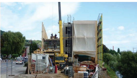
„Rohbau im Bereich des westlichen Fluchttreppenhauses während der Montage“ © Daedalus Engineering s. à r. l.
