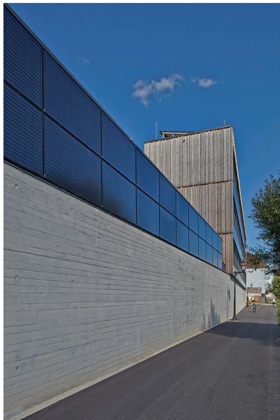
_Uferpromenade mit Sichtbetonwand und architekturintegrierten Photovoltaikanlagen der Südfassaden
