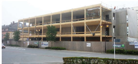
Gebäudeansicht während der Rohbauarbeiten, Holzskelettbau mit Gebäudekern in Stahlbeton
